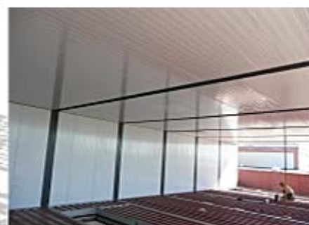
PREPARAÇÃO APLICAÇÃO BETÃO
